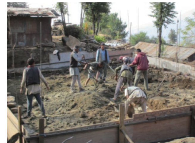
給付金を使った住宅再建の様子(ネパール)
